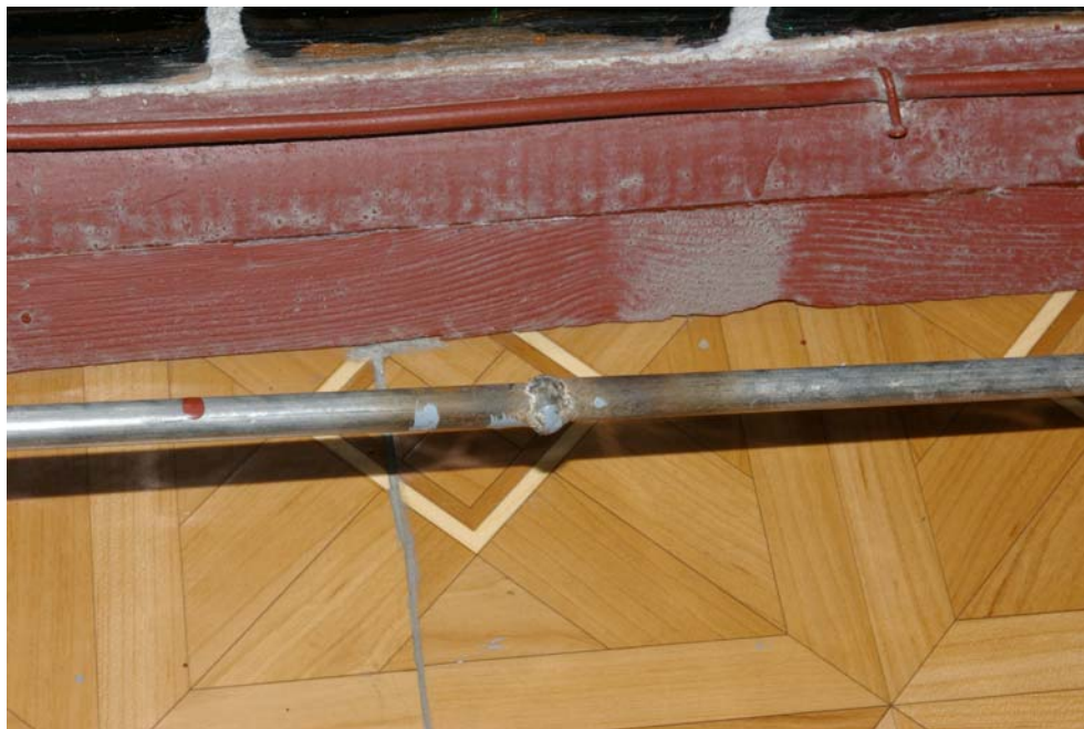
Фото 5 Сварной шов на газопроводе этилена из нержавеющей стали
