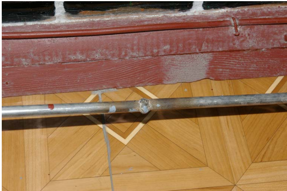
Photo 5 Soudure sur le circuit d'éthylène en acier inoxydable
