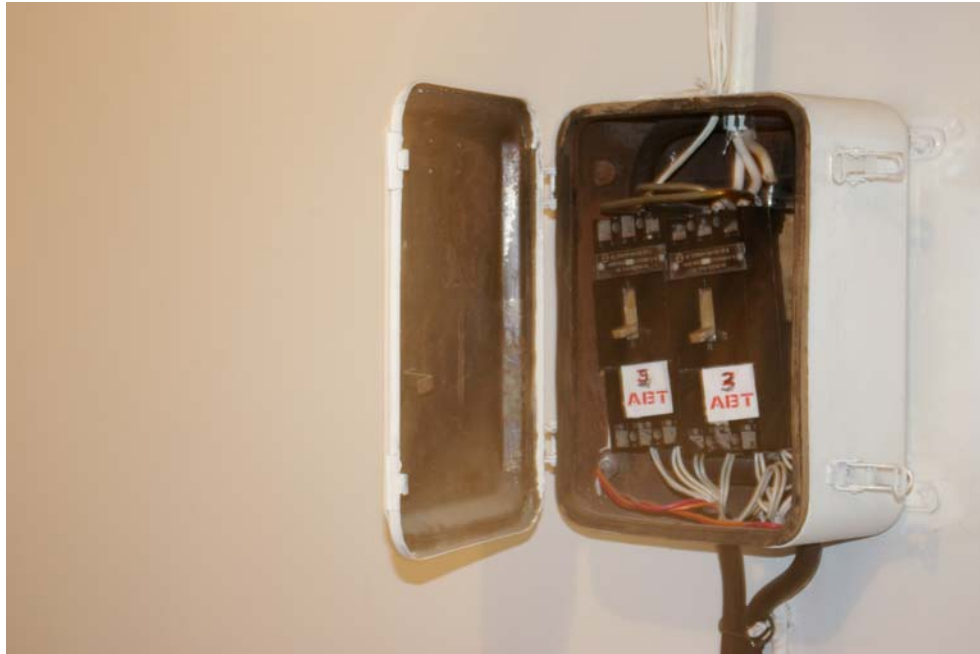
Photo 4 Exemple de branchement d'appareils
